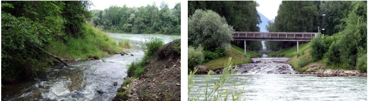
Abb. 5: Niveaugleiche Einmündung der naturnahen Altglan (links) und sohlrampenartiger Mündungsbereich des hart verbauten Glan-Hochwasserdurchstiches (rechts)
