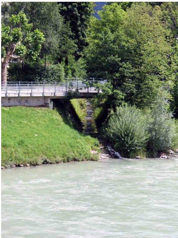
Abb. 3: Heute mündet der Gersbach über eine hohe Stufe in die Salzach und verläuft in einem kanalartigen, gepflasterten Gerinne
